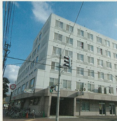
カルムイン美園（北西側外観と地下鉄入口）
